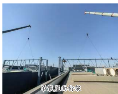
吊装屋面桁架
